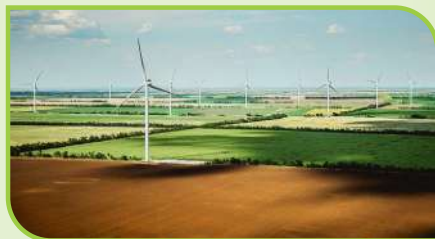
Мал. 122. Ботіївська вітрова електростанція
