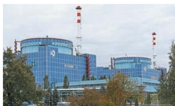
Рис. 27.6. Хмельницька АЕС має 2 атомні енергоблоки
