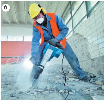
Рис. 36.3. Рух більярдних куль після удару одна об одну (а); віддача відбійного молотка (б) — поява всіх цих рухів є наслідком закону збереження імпульсу
